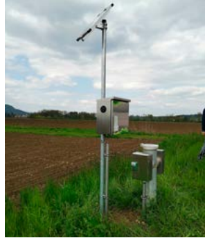
Abgesetzte Bauweise mit Solarversorgung für größeren Parameterumfang und häufigere Messung- bzw. Datenübertragung
